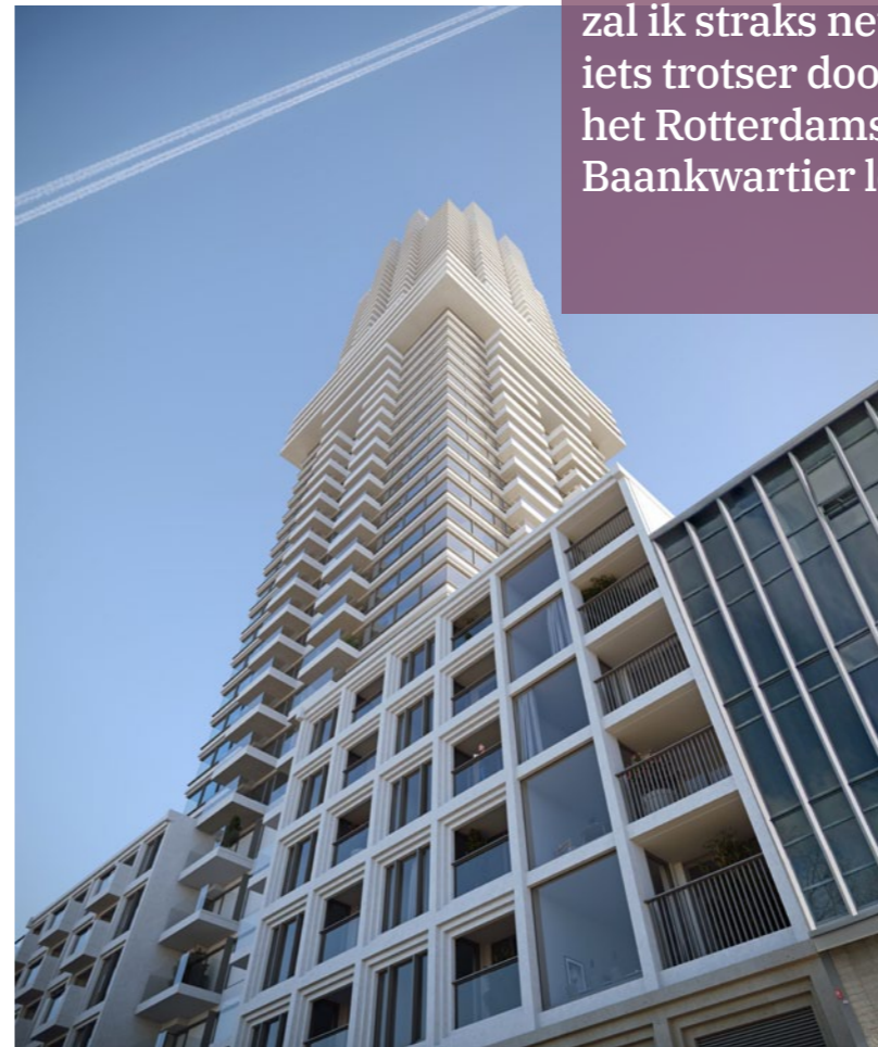
Cooltoren Rotterdam Opdrachtgever: De Vijf Heeren B.V. Architect: V8 Architects
